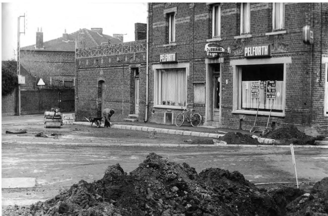
Photo d'archive lors des travaux sur l'ancienne « Place de la Liberté » :
